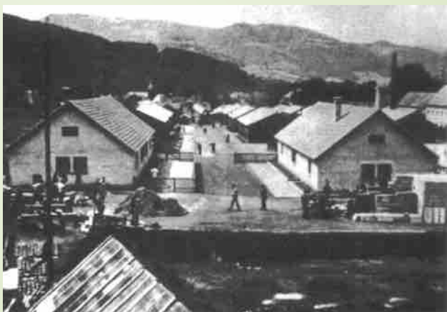
Vue générale du camp de Vorbruck Au premier plan, la salle des fêtes en construction. Au second, deux baraques pour les femmes ; celle de droite en voie d'achèvement et celle de gauche déjà occupée
